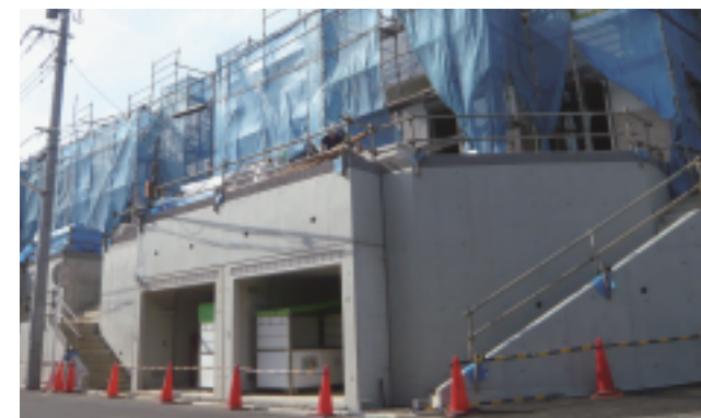
4メートルの擁壁を活かした地下車庫と階段が特徴的な9~13号棟
