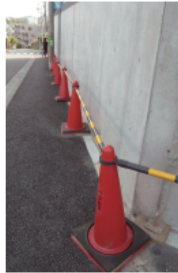
小学校への通学路となるため 安全対策に万全を期しています
